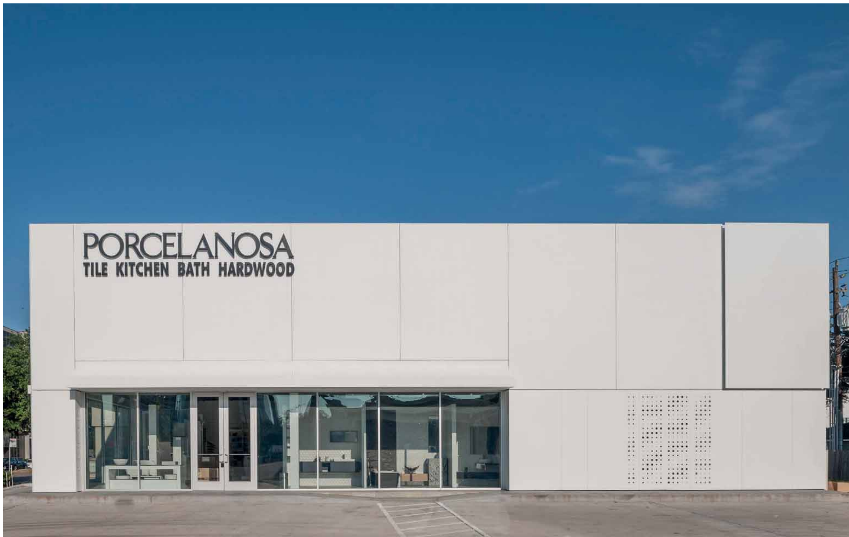
Ventilated façade & KRICN®
