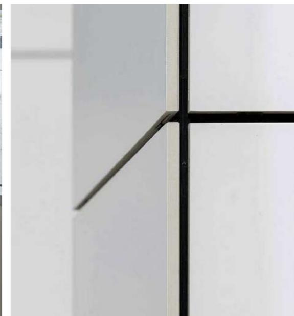
宝瓷兰的Technic Nieve陶瓷面板装饰着奥康奈尔主教高中的正门。这面通风外墙呈现出一种以几何形状为标志的精致美学，采用了FV STON-KER®系统和Butech的隐藏式锚固，它们通过一个高度耐用的可持续解决方案提供更现代和更明亮的外观。
