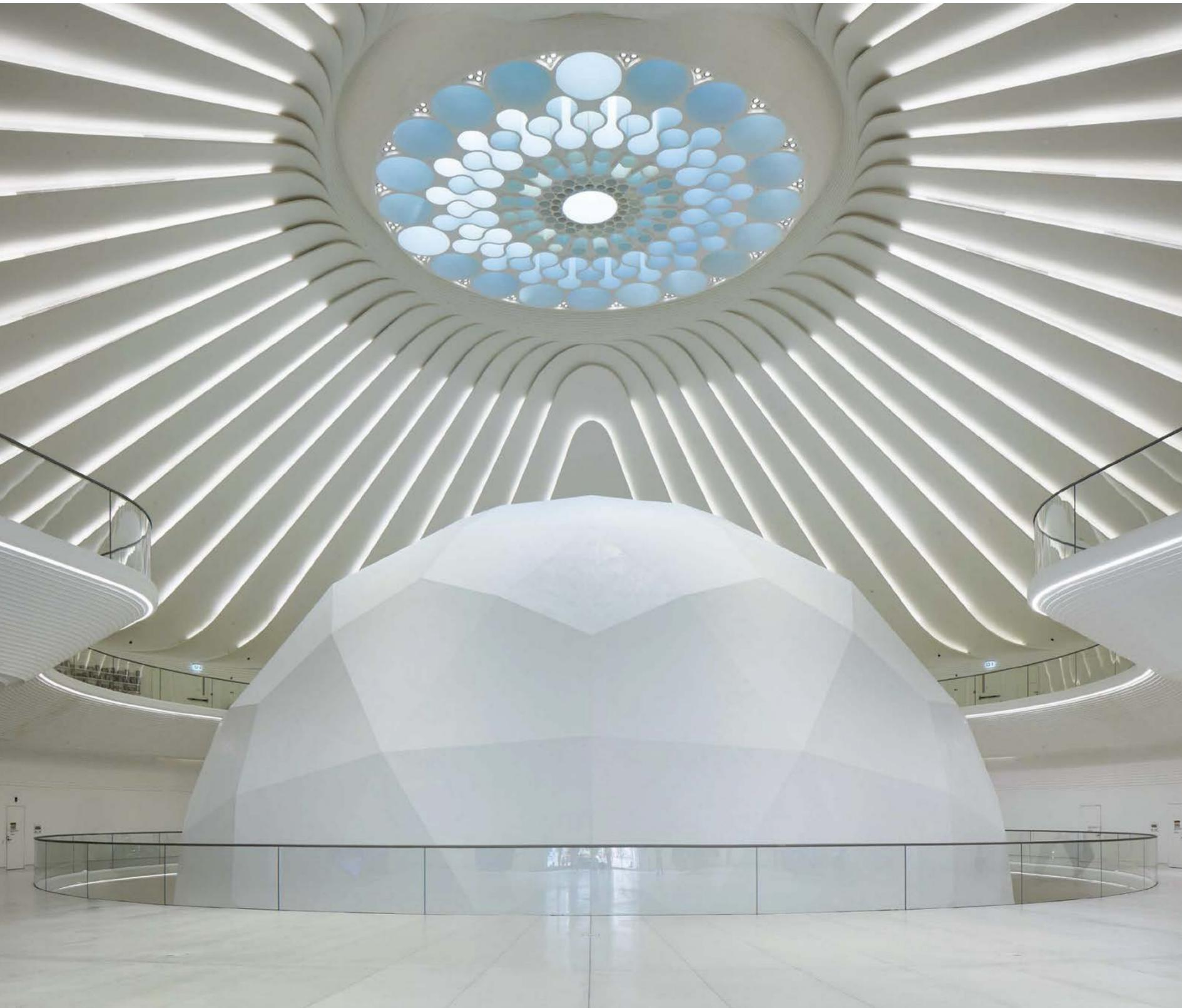
支配阿联酋馆内部的巨大半球体采用 KRION® Lux 1100 K·Life 建造。它的使用带来了空间清晰度和明亮度。
