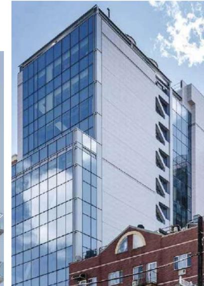
通风陶瓷外墙的单色护面由三种型号的大尺寸墙砖组成: Ferroker Niquel、STON-KER®的Extreme White和Solidker的Deep Light。
