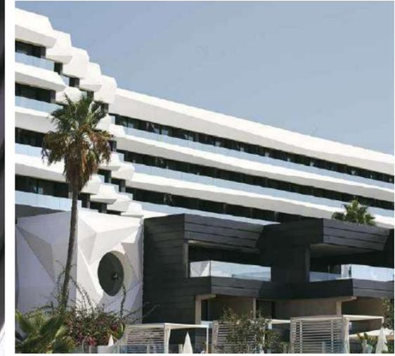
通风外墙采用了XTONE的XLight大尺寸超细高密度岩板以及KRION® LUX 1100 K·Life。所有这一切都以白色为主,与大尺寸的Concrete Black Nature系列以及XTONE的XLight的黑色形成鲜明对比。宽敞的大阳台采用了定制的KRION® Lux型号、隐藏式锚固和Butech的FV XLight通风外墙。安装导轨由铝制成,即使在最恶劣的环境中也能提供高强度和耐用性。
